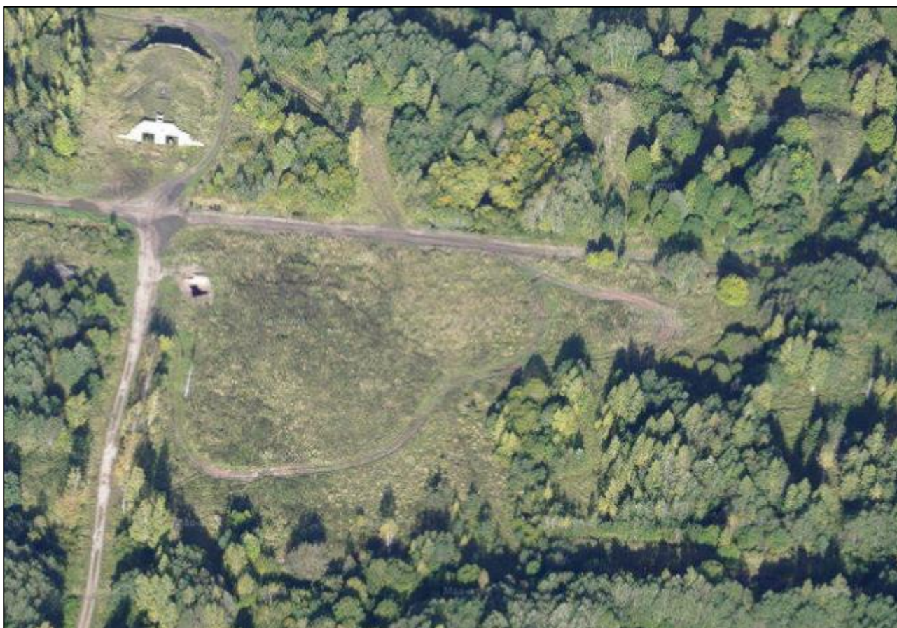
Joonis 26. Asfaltbetoonisegisti asukoht enne alustarindi rajamist (Maa-ameti fotoladu, pildistamise aeg: 23.09.2017)
