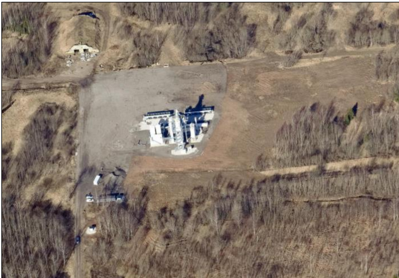
Joonis 27. Asfaltbetoonisegisti asukoht pärast alustarindi rajamist ja segisti paigaldamist (Maa-ameti fotoladu, pildistamise aeg: 23.03.2020)
